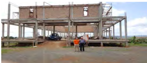
Gx đang trong công trình xây dựng
